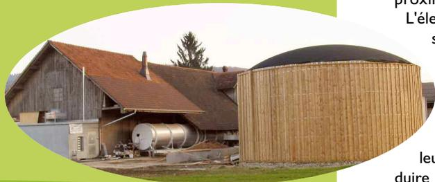
**La cogénération** permet de produire simultanément de la chaleur et de l'électricité. La récupération de l'importante quantité de chaleur perdue lors de la production électrique permet d'améliorer le rendement. La chaleur est utilisée sur place, ou distribuée à proximité via un réseau de chaleur.
