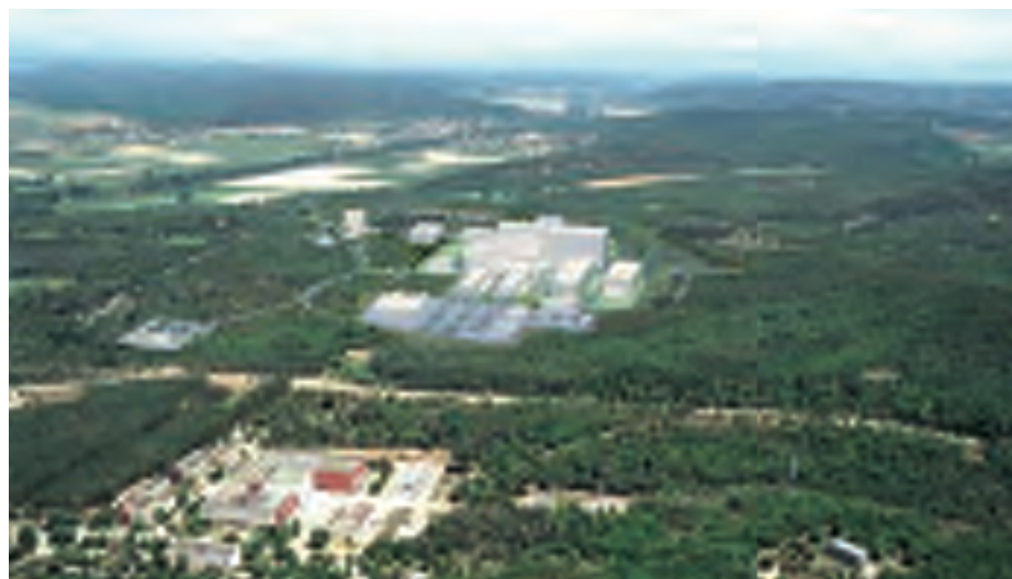
▲ Site de l'ITER à Cadarache (13)
